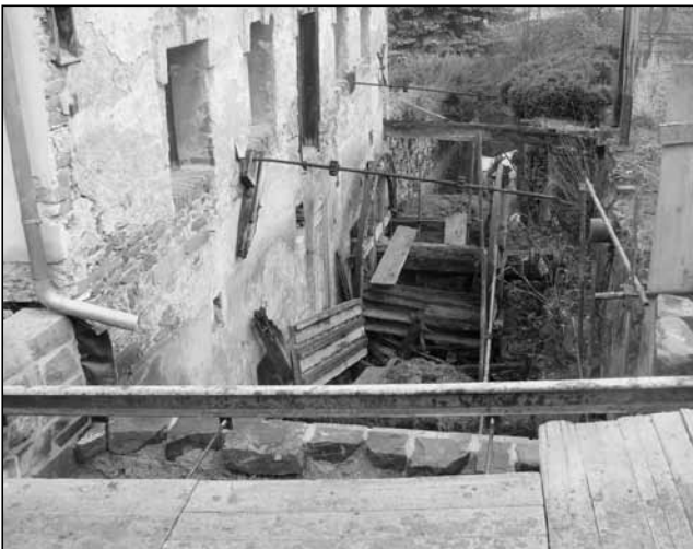
Pohled na náhon – do lednice – před opravami, vyklížením trosk původních kol a metrového nánosů bahna a jiných nánosů (Foto František Mikyška).
