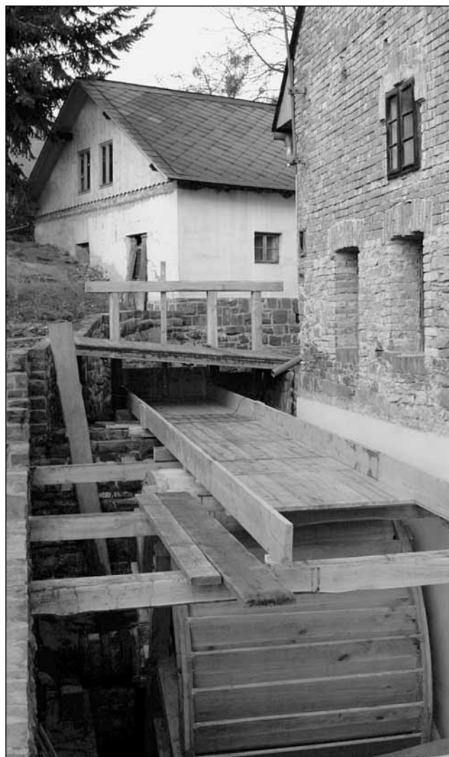
Pohled na hotové mlýnské kolo a jeho uložení v lednici (Foto Petr Grambal).
