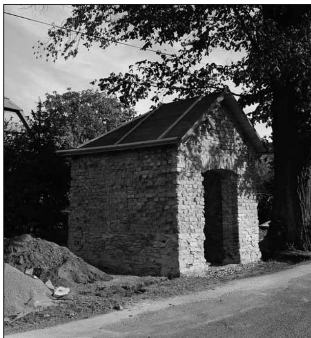
O tom, že oprava byla provedena „z gruntu“, svědčí tato fotografie.
