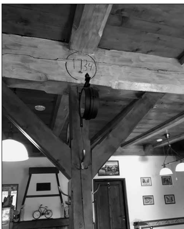
Mohutné trámy v interiéru objektu s letopočtem 1734.
