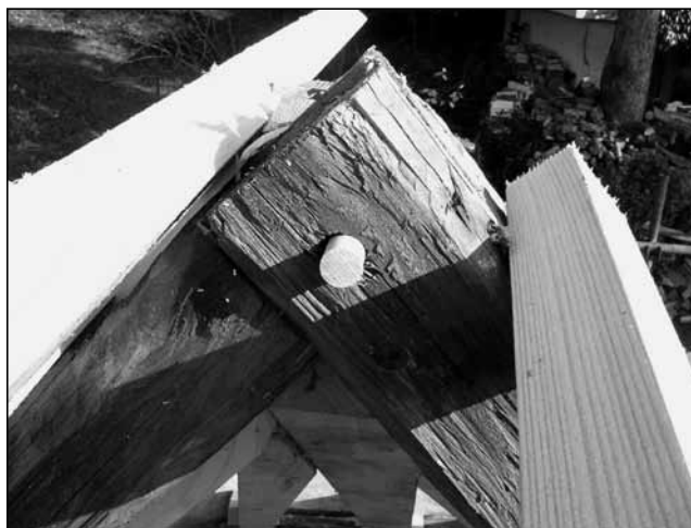
Ke spojení jednotlivých dílů byly využity dubové kolíky.
