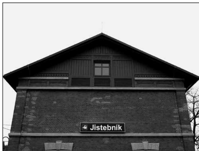
Obnovené bedněné štítové strany, 2019.
