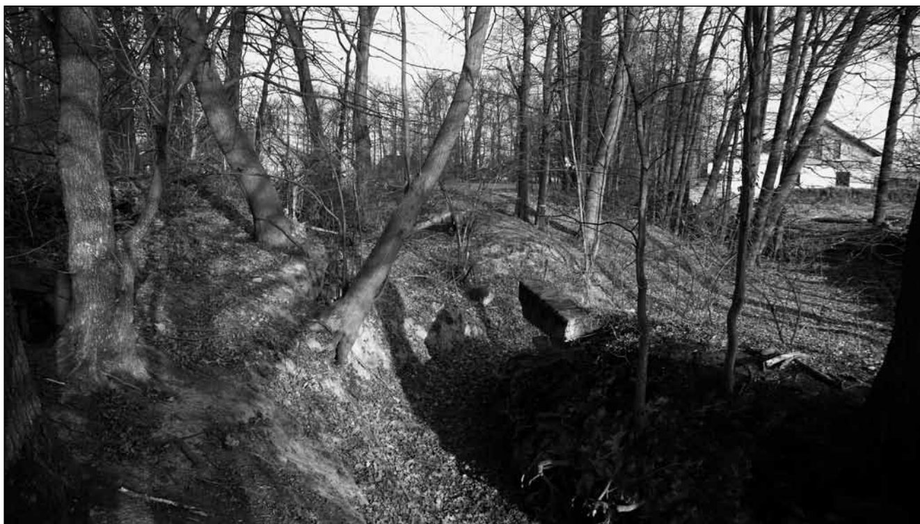
Zbytek betonového rozdělovacího objektu na náhonu nad mlýnem. Manipulací na stavidle se mohl průtok podle potřeby dělit – vlevo šla voda na mlýnské kolo, vpravo mlýn obtékala. Zcela vpravo dům je č. p. 61.
