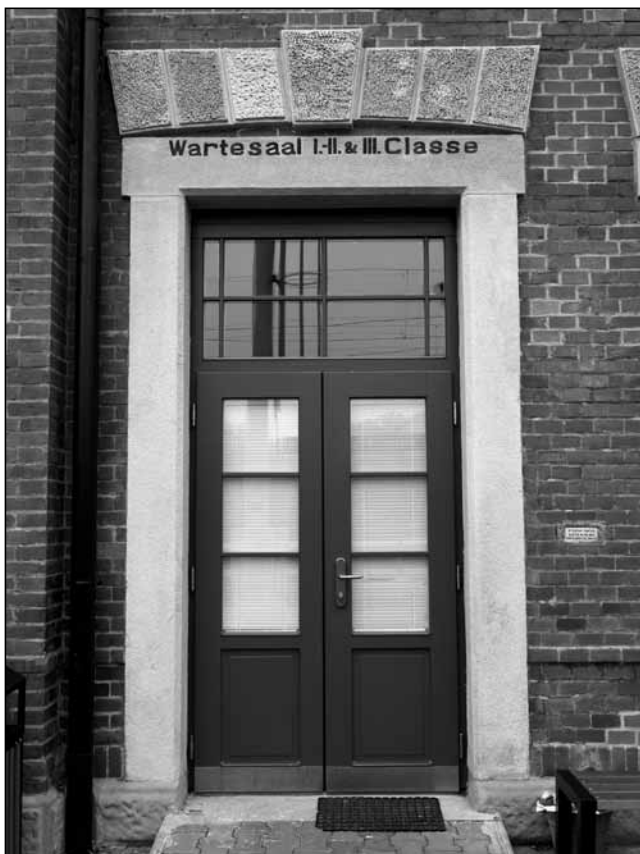
Vstupní dveře do dopravní kanceláře (původně čekárny) s obnoveným horním nápisem, 2019.
