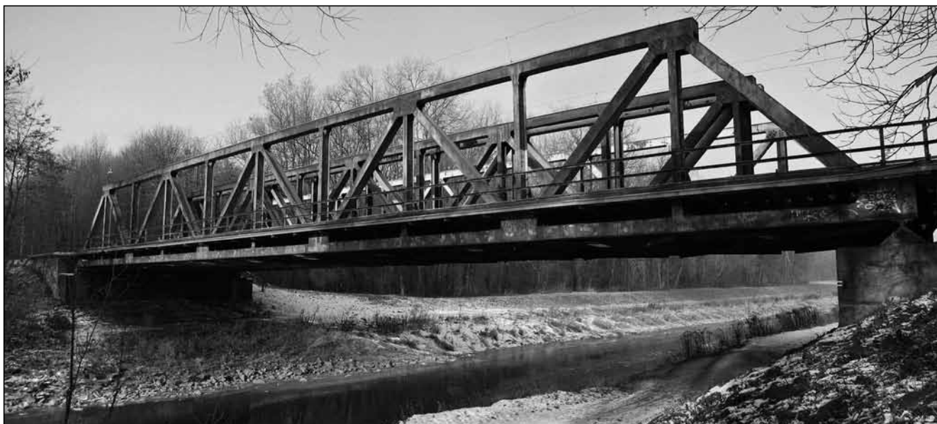
Stav mostu okolo 2010 (Foto Antonín Pašata).
