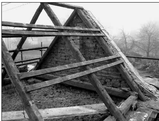
Z opravy střechy – původní krov byl silně poškozený.
