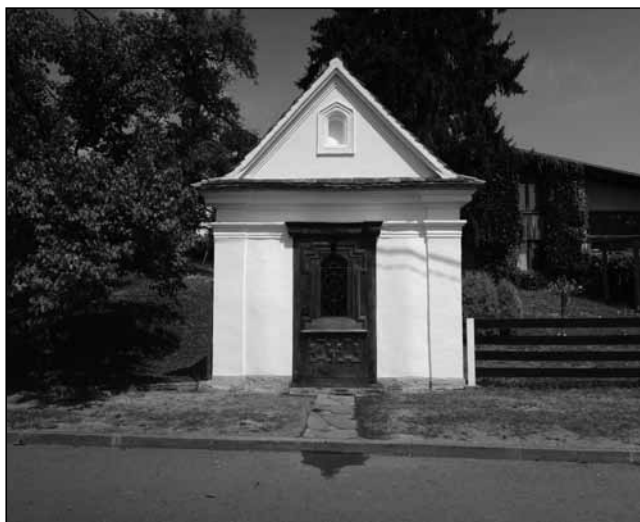
Čelní pohled na kapli po opravě.
