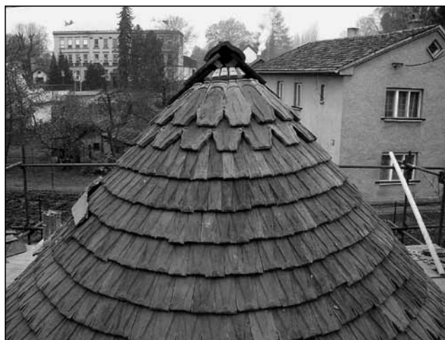
Kuželová část střechy s novou krytinou.
