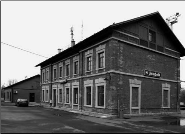
Výpravní budova v Jistebníku po rekonstrukci, pohled z ulice, 2019.
