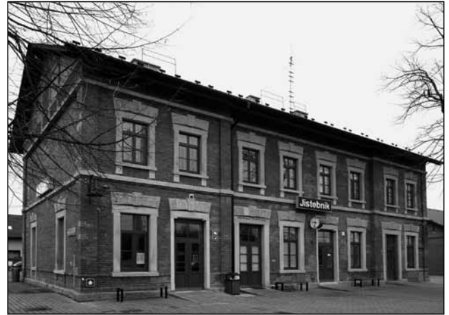
Výpravní budova po rekonstrukci, pohled od dráhy, 2019.
