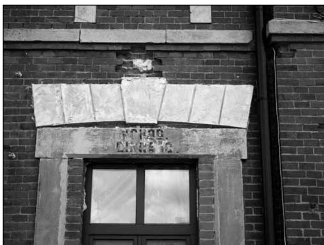
Průběh doplnění a opravy záklenku, 2019.
