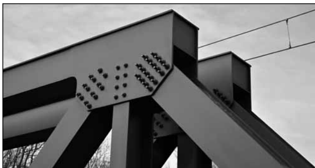
Detail konstrukce, listopad 2019 (Foto autor).
