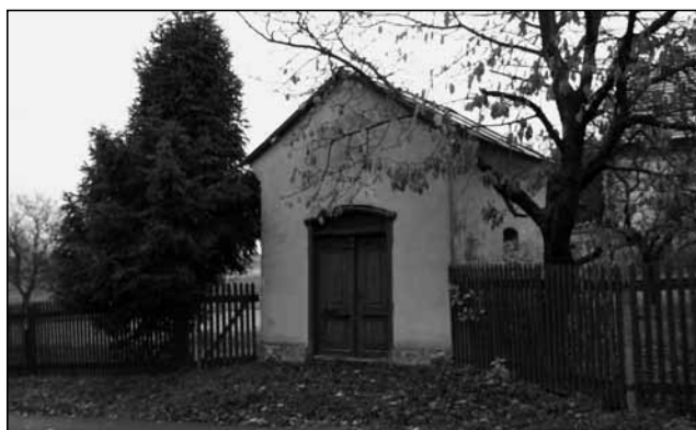
Současný stav kapličky.
