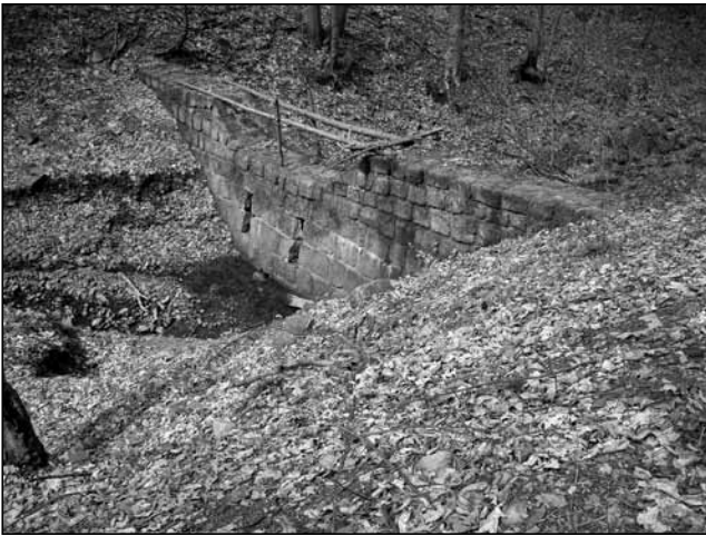
Kamenná přehrážka v dolní části potoka s předprahem a opevněním dna a boků vývaru kamenným záhozem.
