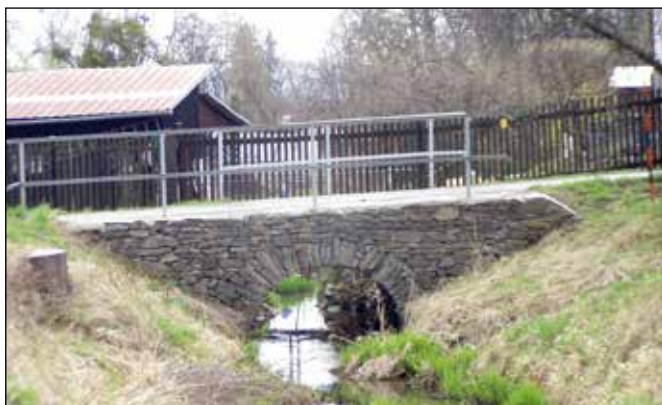
Kamenný propustek u vodního mlýna v Loučkách.
