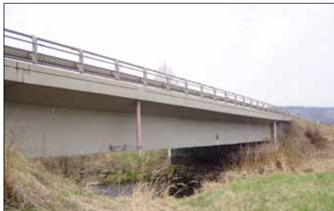
Železobetonový silniční most u Jakubčovic n. O. v současnosti.
