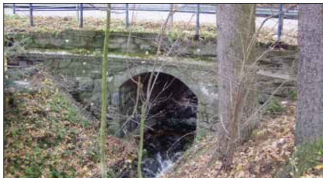
Kamenný propustek nad Skalními sklepy v Odrách.
