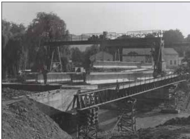
Stavba nového mostu na tř. Osvobození v červenci 1966.
