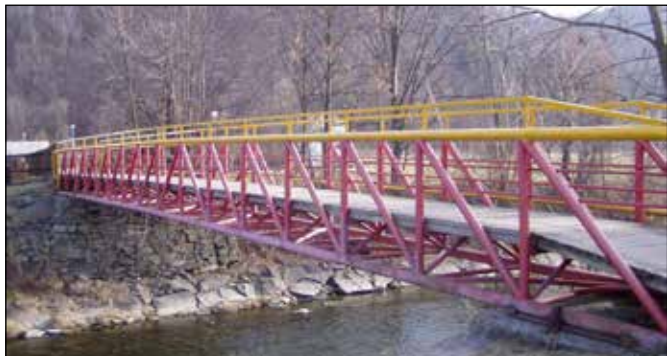
Ocelová příhradová lávka v Jakubčovicích n. O. v současnosti.
