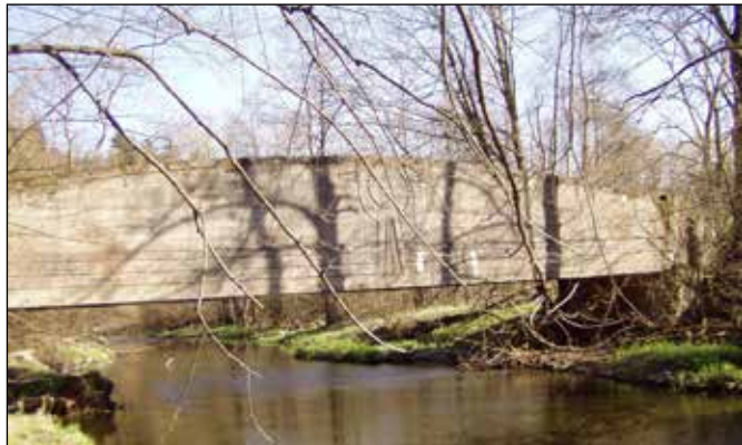
Historický železobetonový mos u Nových Oldřůvek.
