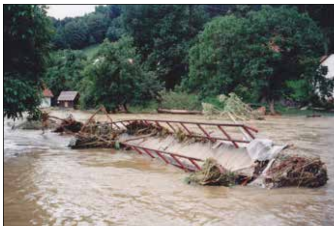
Pěší ocelová lávka v Loučkách pod MŠ za povodní v roce 1997.
