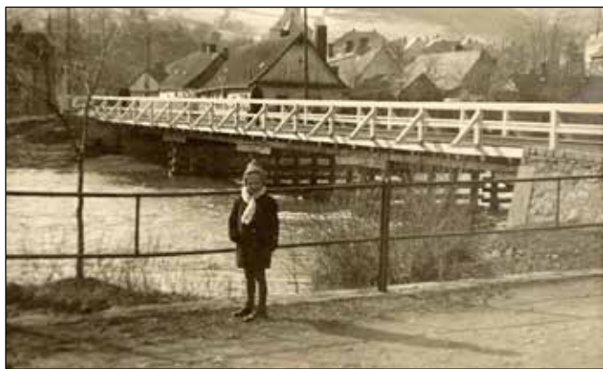
Most na Skřivánčí ulici po opravě v roce 1945.
