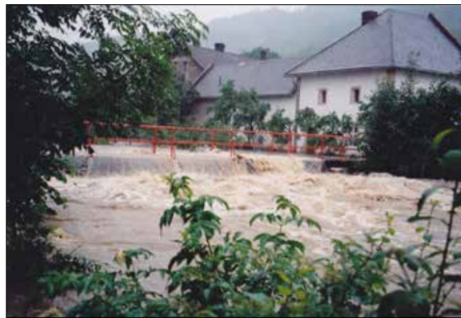
Pěší lávka v Jakubčovicích n. O. u návsi za povodně v roce 1997.
