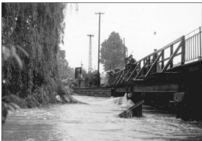
Nouzový most přes Odru zřízený při povodni v roce 1953.
