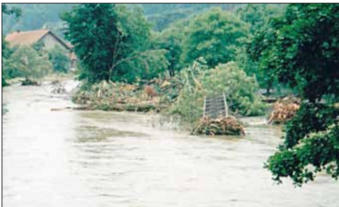
Ocelová příhradová lávka v Loučkách za povodně v roce 1997.
