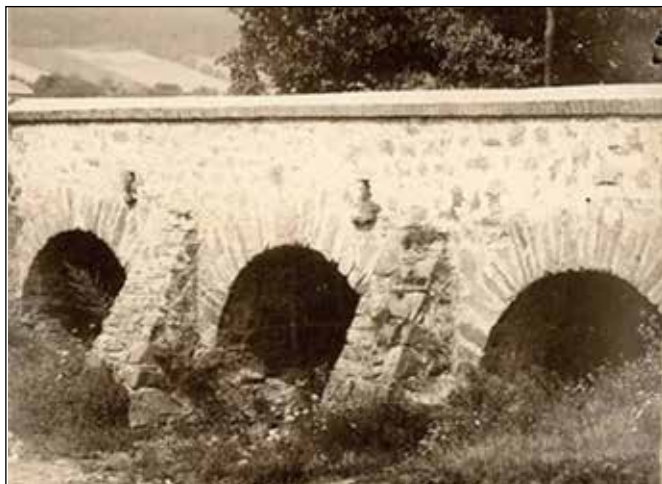
Propustky v předmostí Jahnova mostu.
