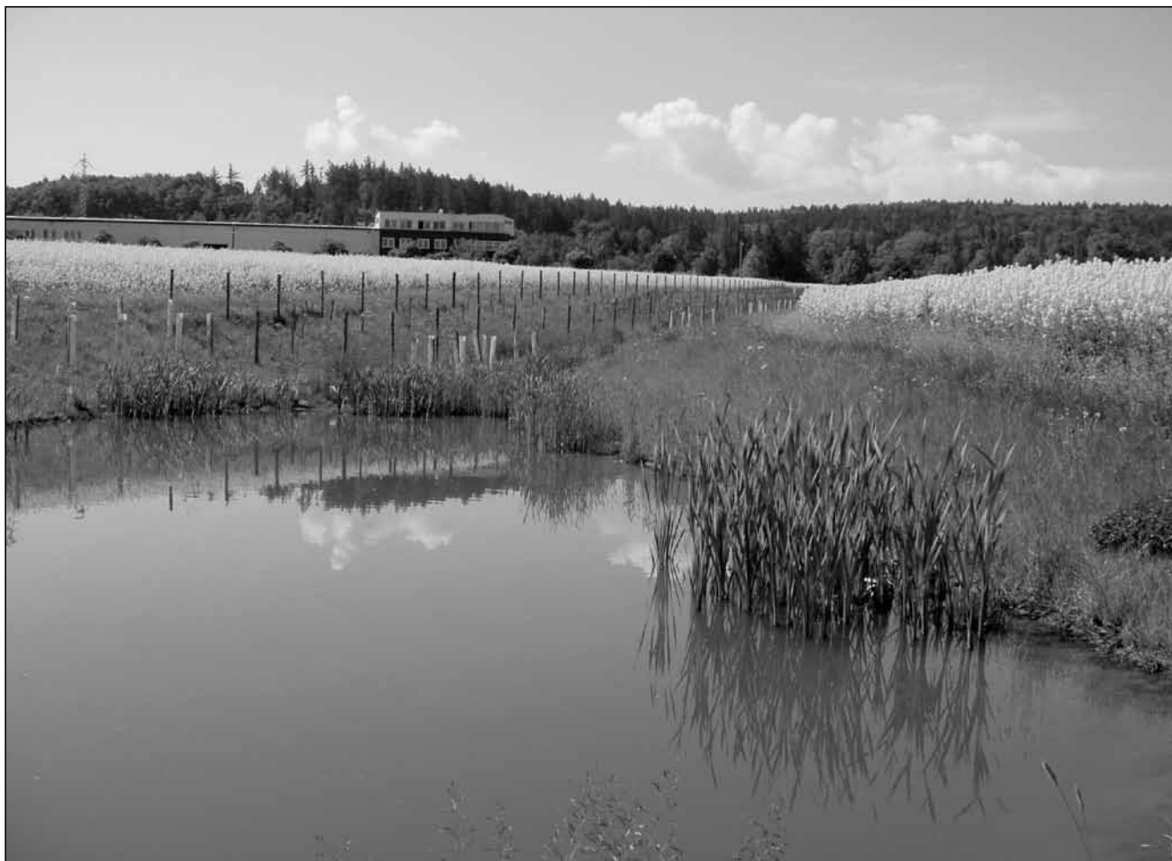
Po realizaci. V zatravněném pásu, který byl mírně zahlouben do terénu jako nová potoční niva, se vine potůček, byly vysazeny stromy a keře, vytvořeny dvě tůňe a nad obcí rozlivná plocha jako mokřad s vrbami. Odvodnění polí kolem bylo zachováno a ústí do potoka.
