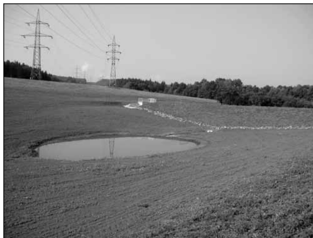
Technické řešení – poldr u Kateřinic, který je prostou hrází zachycující přívalové srážky – je obohaceno o vodní plochu, dno poldru bylo zatravněno. Zatrubnění přítoku bylo zrušeno a upraveno do podoby otevřeného koryta, byly vysazeny dřeviny – bohužel již mimo záběr.
