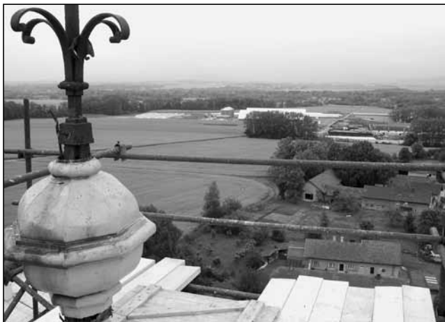
Báňka na vrcholu věže před opravou, pohled směrem k Odře.
