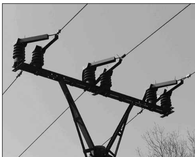
Nejnovější typ ochrany proti úrazům ptáků el. proudem – typ OKI.
