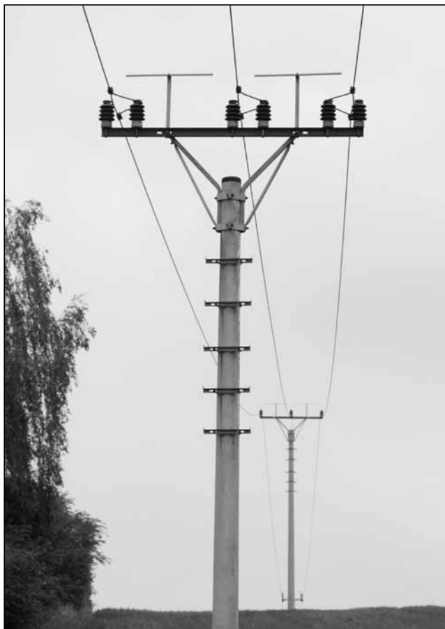
Prvním počinem k ochraně ptáků při dosedání na sloupy el. napětí byly tzv. lavičky, které byly v Poodří hojně instalovány v bývalém okrese Nový Jičín.
