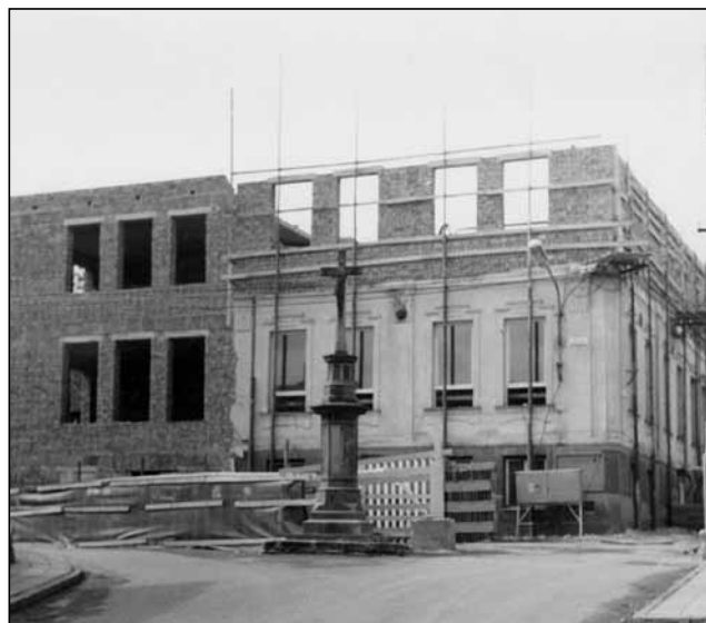
Rekonstrukce a přístavba v letech 1976–1977.
