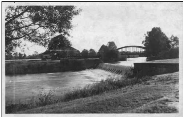
Historická fotografie zachycuje železobetonový obloukový most přes Odru v Polance, který se zřítíl po povodni v r. 1940, Hurníkův splav a hospodu Honculu.
