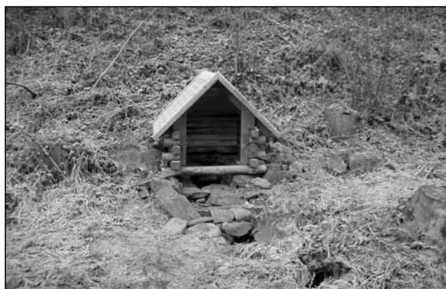
Studánka po opravě.
