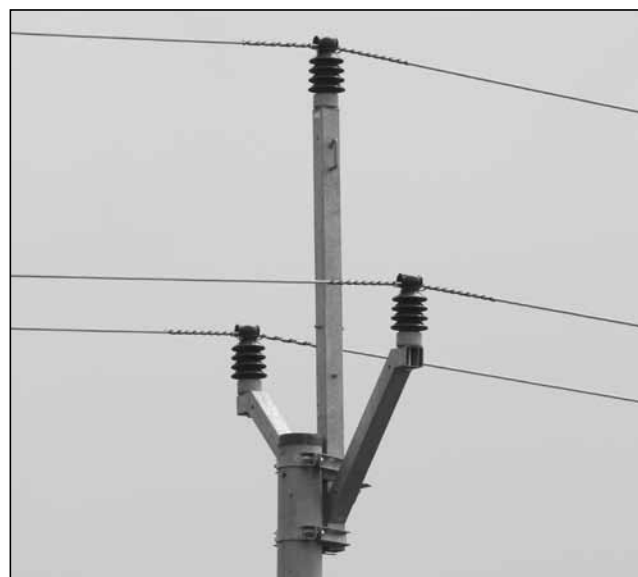
Moderní způsob ochrany ptáků před kontaktem s el. proudem představují nosné sloupy el. vodičů typu pařát.
