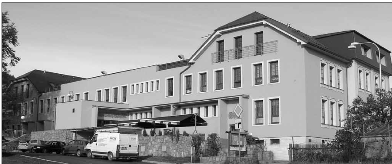
Dělnický dům po rekonstrukci, r. 2007 (Foto Petr Šustek).
