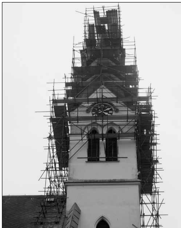
Lešením zakrytá horní část věže.
