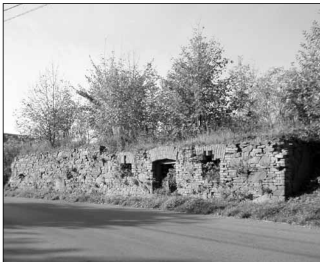
Dnes zůstaly z bývalé mohutné budovy fojtství jen základy. (Foto Petr Lelek, 2006)
