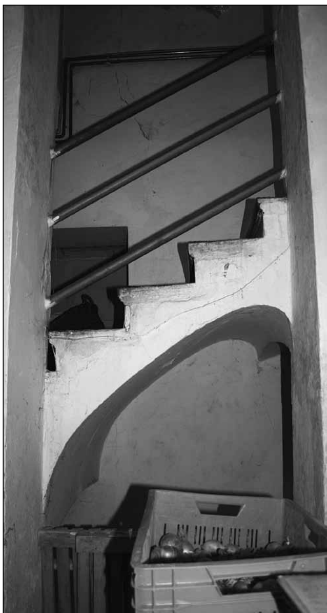
Detail podklenutého schodiště, foto, 2009.
