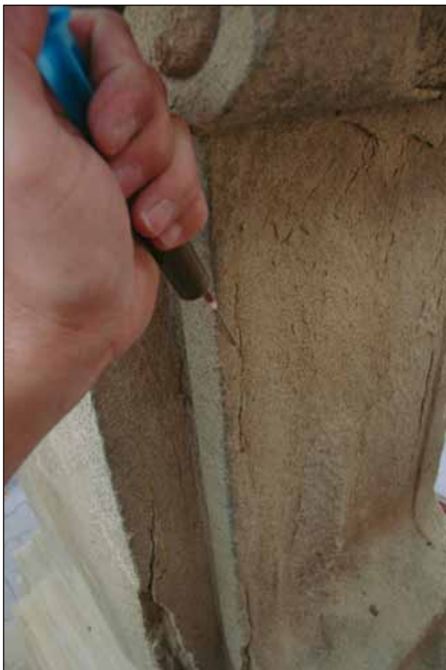
Konsolidace kamenného materiálu – bylo provedeno opakované napuštění kamene prostředkem, který zpevnil jeho strukturu a zamezí do budoucna jejímu rozpadu. Trhliny a praskliny v materiálu byly injektovány.
