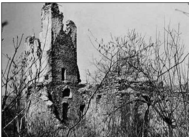
Stav kostela v nedávné době. Foto Jindřich Machala.
