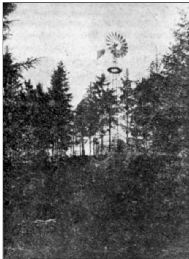
Větrné kolo pohánějící čerpadlo na historickém snímku.
