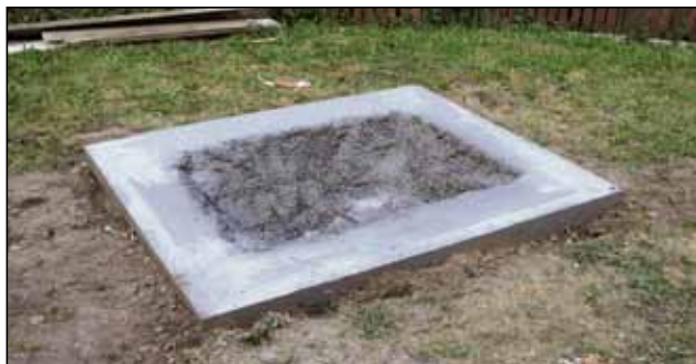
Úprava základu a okolí – jelikož byla památka před transferem „utopena“ v terénu, bylo nutné zhotovit základ nový. Základ byl proveden z betonu, do šalování o rozměrech 220x180 cm, do hloubky 100 cm.
