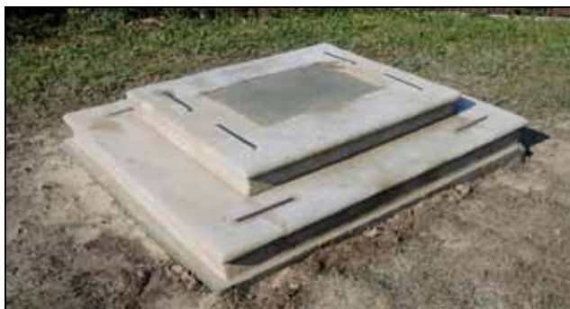
Transfer a osazení – osazování probíhalo ve dvou etapách. Nejprve byla osazena spodní řada schodů, které byly zajištěny kramlemi. Vnitřní prostor byl zalit betonem do jejich úrovně. Následovalo osazení horní řady schodů stejným způsobem včetně dolití vnitřního prostoru betonem.
