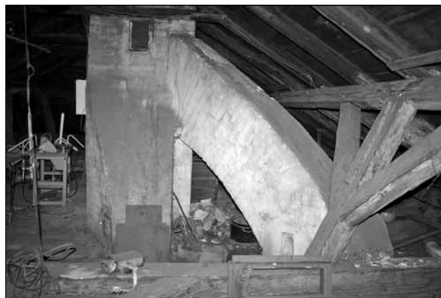
Podkroví hostince s kominovým tělesem, do něhož se napojují další sopouchy, foto, 2009.
