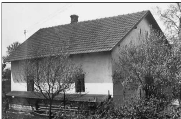
Dům čp. 38 – budova MNV postavená v roce 1928.
