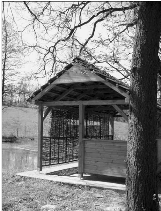
Dokončená pozorovatelna (Foto Radim Jarošek).
