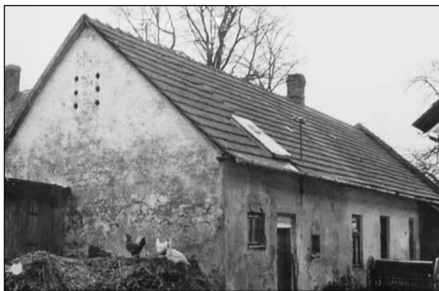
Čp. 40 – hasičská zbrojnice.
