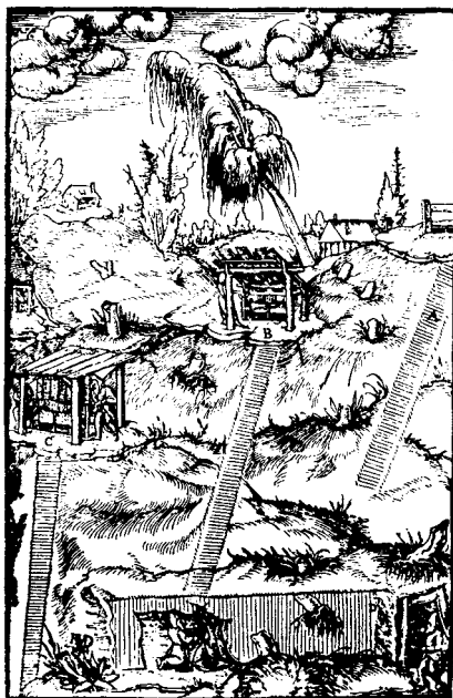
Základní důlní díla období české báňské techniky - štoly a úklonné šachty
