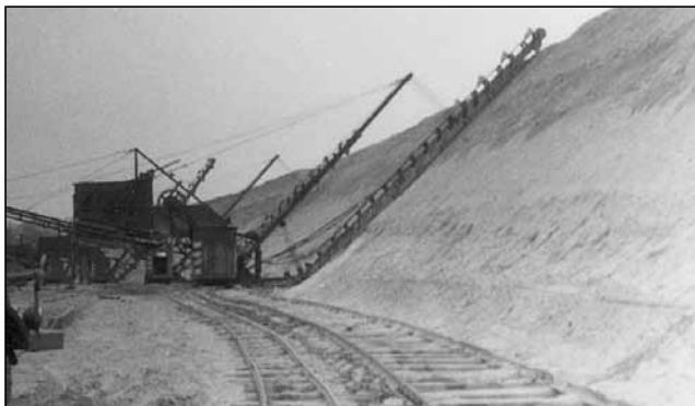
Těžba cihlářské suroviny korečkovým rypadlem (foto: J. Novosad)
