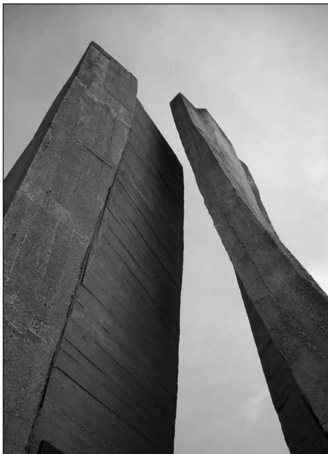
Členění vnějšího pláště vyvolává vjem padajících vodních proudů, dvou rozcházejících se vod.
