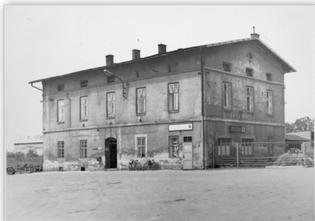
Panská hospoda Na Špici – č. p. 136 u nádraží ve Studénce (dnes hostinec Budvarka).
